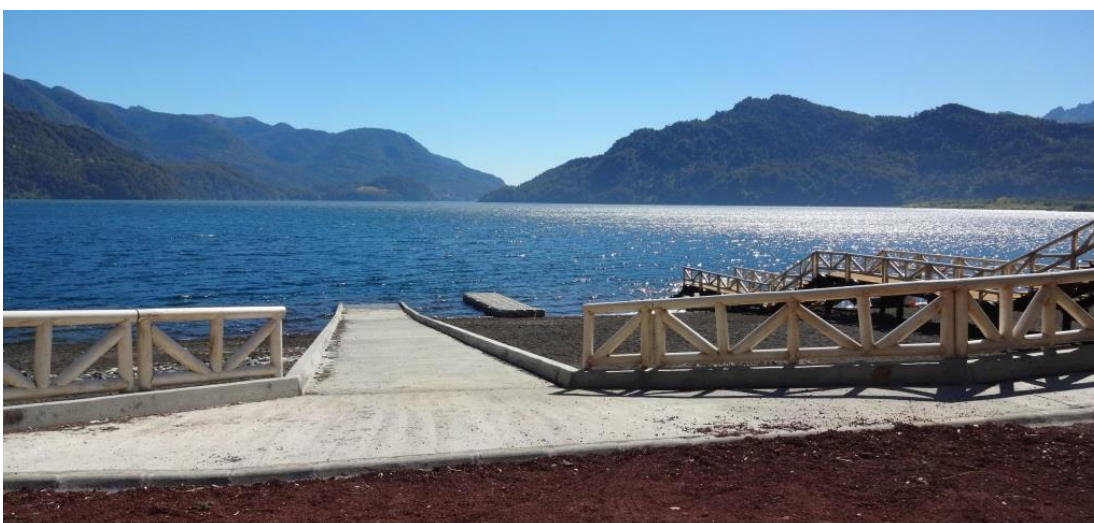
Figura 19. Rampla de acceso Lago Panguipulli, sector Choshuenco. (Fuente: Elaboración propia).
